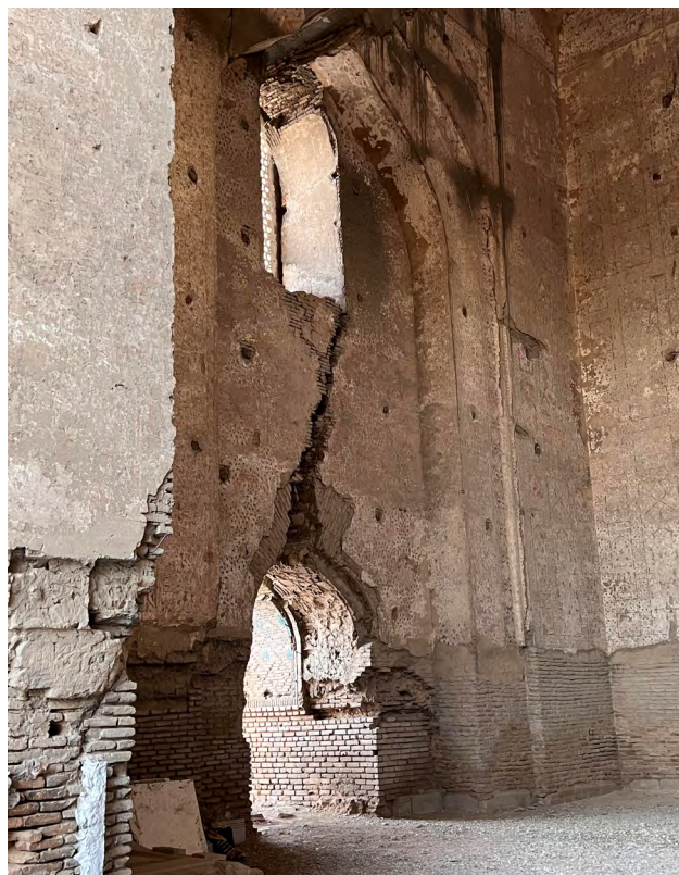
Wnętrze meczetu Bibi Chanum zniszczone w wyniku trzęsienia ziemi w 1897 roku | fot. Krzysztof Gaidzik
